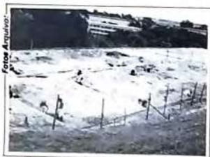
Construção de oficinas na Fatec-Americana
