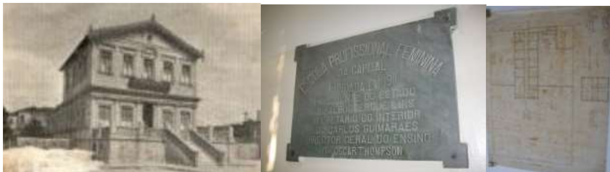
FIGURA 1 - Primeiro edifício da Etec Carlos de Campos, entre 1911 e 1976, em 2016; FIGURA 2 - Placa de inauguração da Escola Profissional Feminina no edifício construído entre 1927 e 1930, em 2016; FIGURA 3 - Planta do edifício da Escola Profissional Feminina, com carimbo de 1911, em 2016. Fonte: Acervo do Centro de Memória da Etec Carlos de Campos, em 2016.
