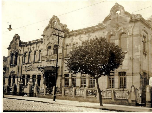
Figura 4 – Fachada do edifício escolar na Rua Piratininga.
