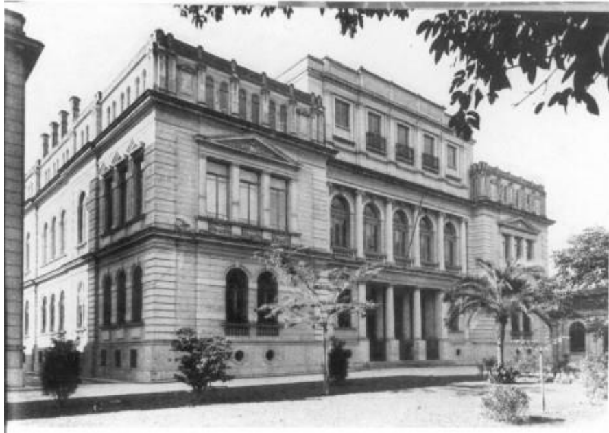
Figura 8: Edifício Paula Souza na década de 1940
