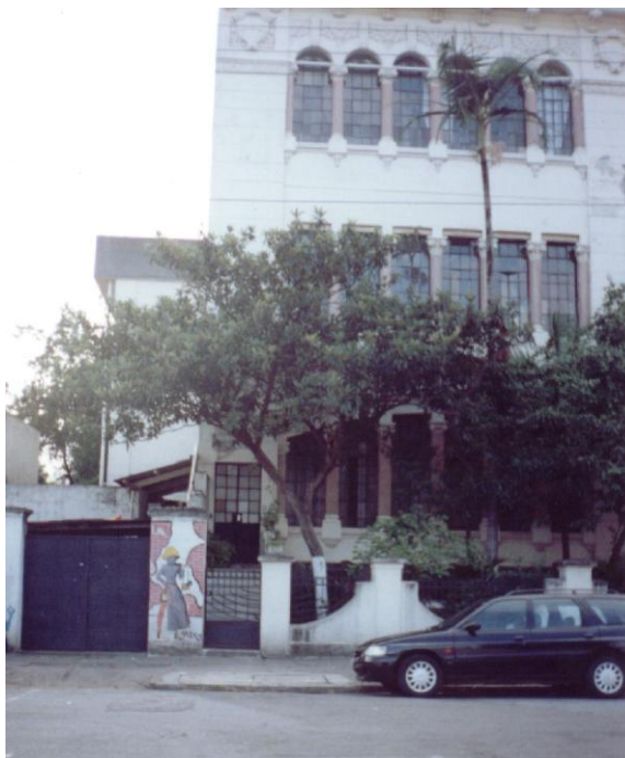
Figura 118 – Entrada principal do Dispensário de Puericultura que funcionou na primeira Escola Profissional Feminina, da capital, entre 1931 e meados da década de 1970. Atualmente é o Centro de Memória da Etec Carlos de Campos, em 2002.
