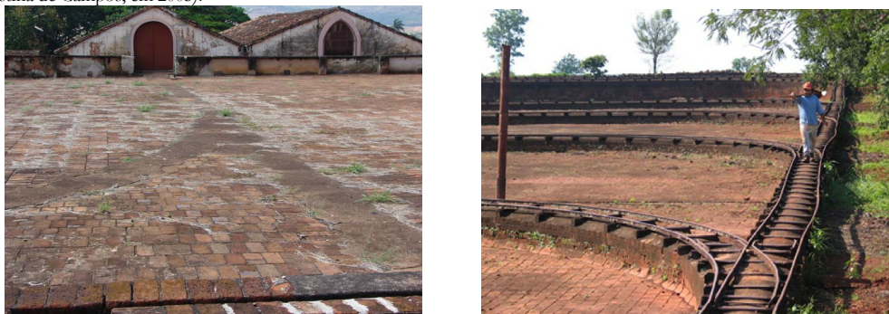
Figuras 62 e 63. À esquerda, terreiro de café da Fazenda Santa Maria, São Carlos - SP. Vêem-se ainda vestígios dos trilhos seguindo em direção à tulha. (Imagem feita por Cristina de Campos, em 2006). À direita, vê-se um complexo de trilhos Decauville nos terreiros de uma fazenda (Imagem gentilmente cedida por Eduardo Roxo Nobre).
